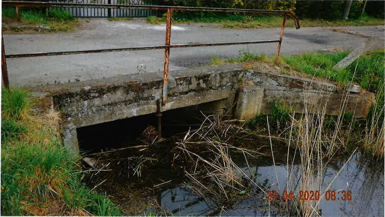
Budowla nr 1. Jaz km 0+236
