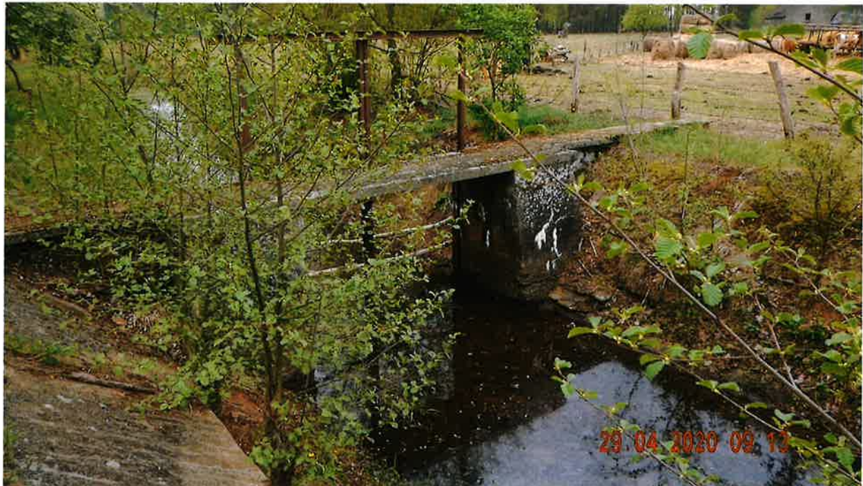
Budowla nr 2. Jaz w km 5+060
